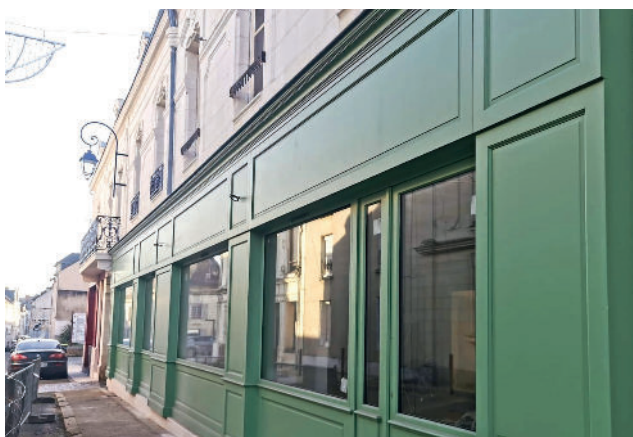
La façade du 24 Rue du Boeuf, rénovée selon les critères du label "Petites Cités de Caractère"
